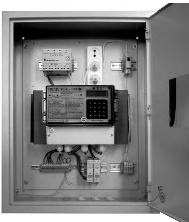
Рис.1 СИ ИСТОК-ГАЗ-03, внутренняя компоновка в монтажном шкафу
