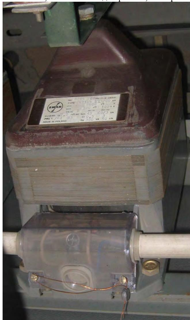
Магнитопровод трансформаторов стержневого типа, обмотки расположены концентрически. Основная вторичная обмотка предназначена для измерения и учета электроэнергии, дополнительная вторичная обмотка – для защиты, питания цепей автоматики, управления, сигнализации или для контроля изоляции сети.
