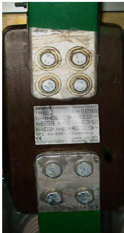
Первичные и вторичные обмотки залиты эпоксидным компаундом, который обеспечивает основную изоляцию и формирует корпус трансформатора. Выводы первичной обмотки выведены на верхнюю часть корпуса в виде контактных площадок. Вторичные обмотки выведены в коробку для зажимов, закрытую крышкой. Крышка, закрывающая зажимы, пломбируется для исключения несанкционированного доступа.
