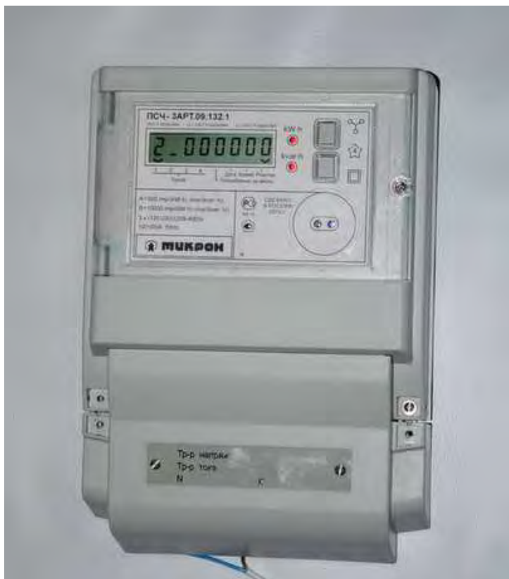
Рисунок 1 – Внешний вид счетчика с закрытой крышкой клеммной колодки
