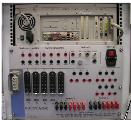
Шкаф. Вид сзади
