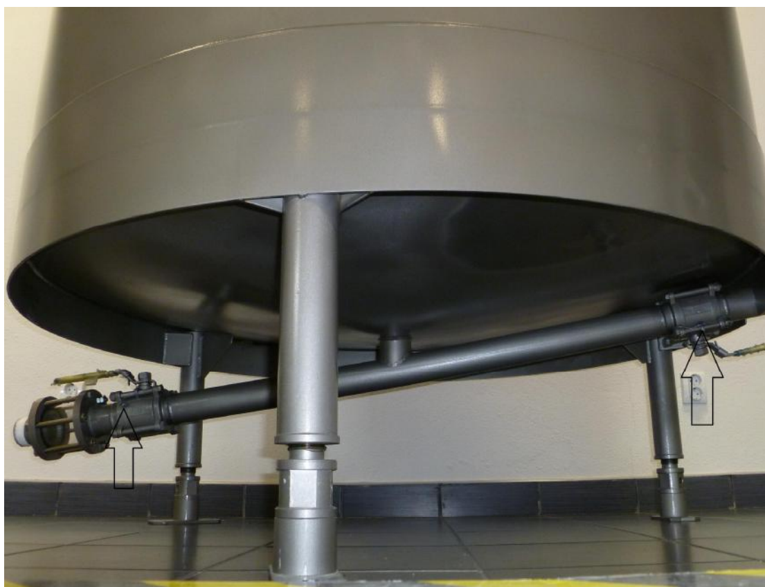
Рисунок 2-3 Места пломбировки от несанкционированного доступа
