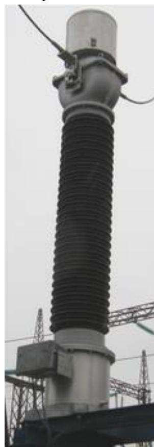
Конструктивно трансформаторы комбинированные KOTEF 245 представляет собой трансформатор тока и индуктивный трансформатор напряжения, изготовленные как единый блок с общим фарфоровым изолятором. Детали трансформатора тока находятся в головной части, а трансформатора напряжения – в баке у основания.
