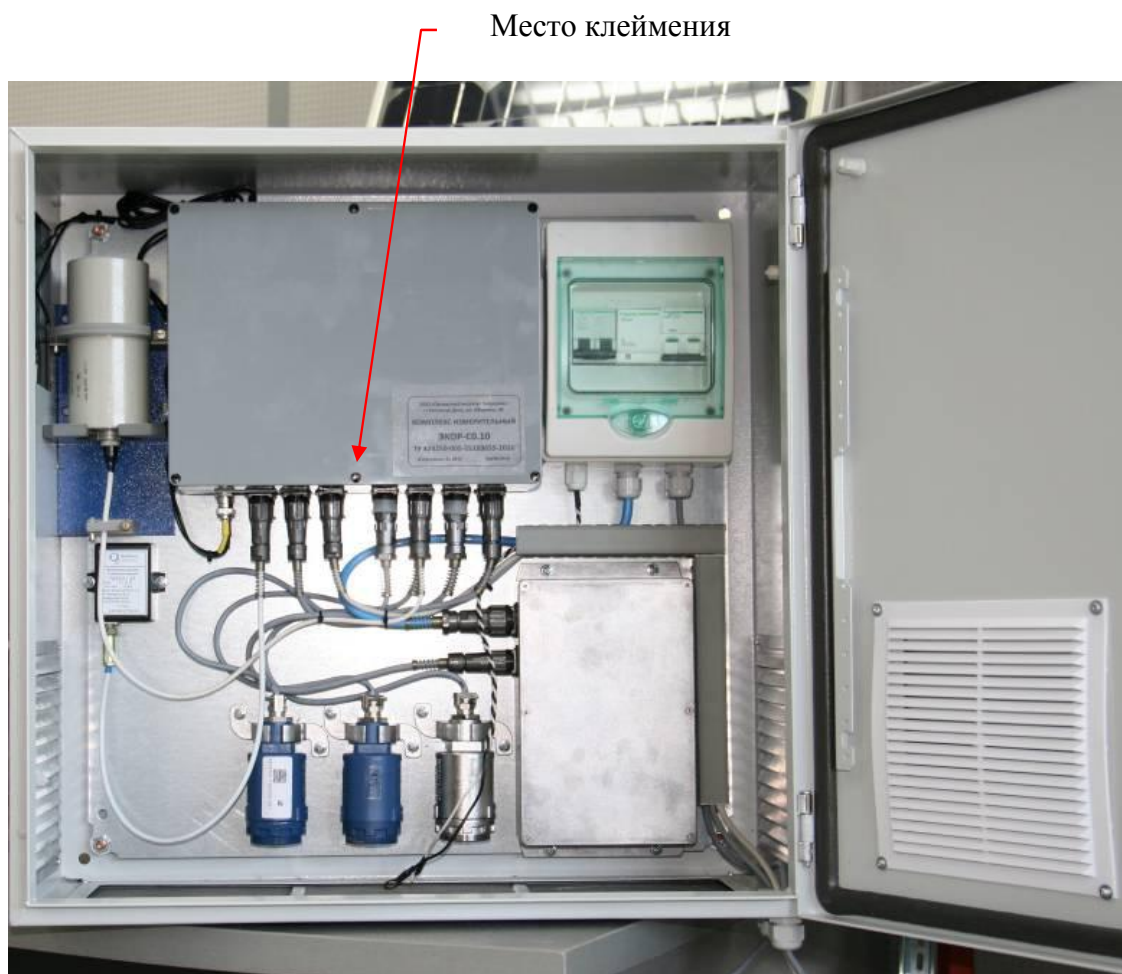
Рисунок 2 - Места нанесения поверительных клейм
