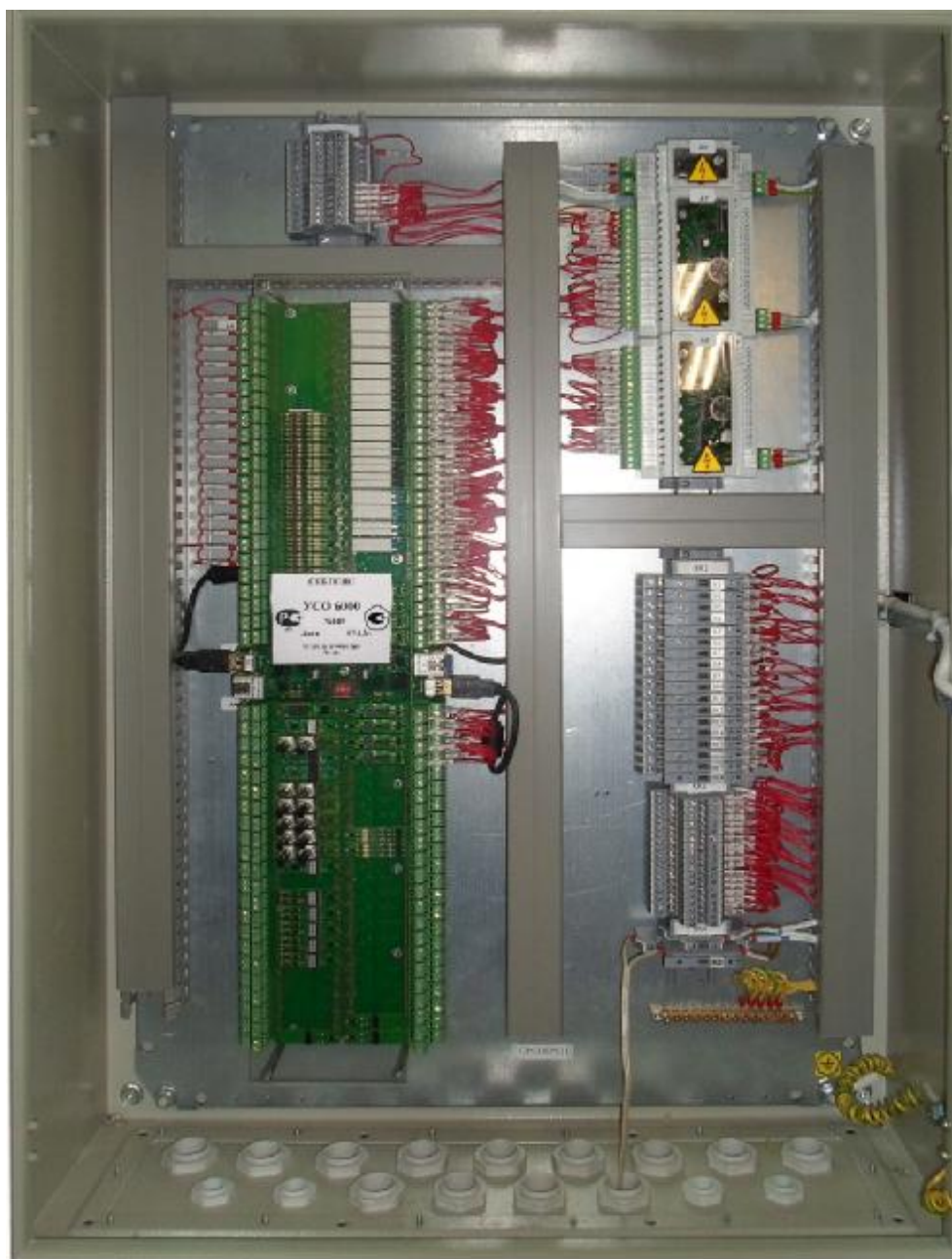
Рисунок 1. Фото общего вида УСО 6000 в монтажном шкафу.
