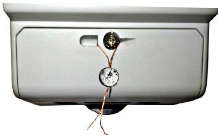
Рисунок 3. Место установки пломбы управляющей компании.
