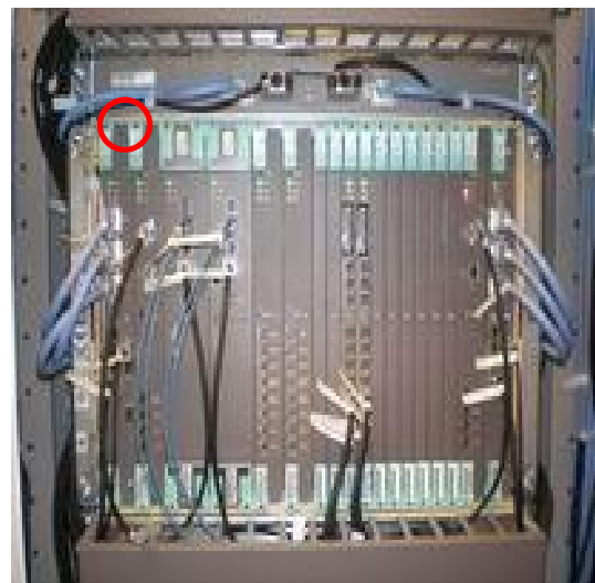
Рисунок 2 Место блокировки кассетного модуля (выделено)
