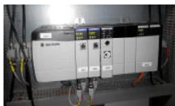
Контроллер ControlLogix
