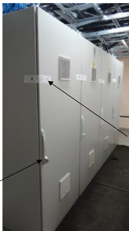
Шкафы контроллера ControlLogix с модулями ввода/вывода
