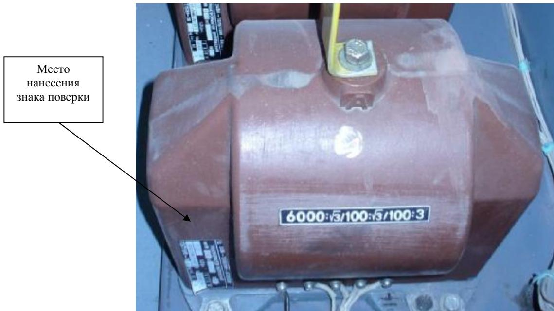
Рисунок 1 - Фотография внешнего вида трансформаторов НК I 72
