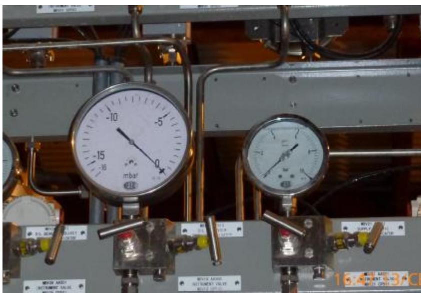
Рис. 1. Общий вид вакуумметра.
