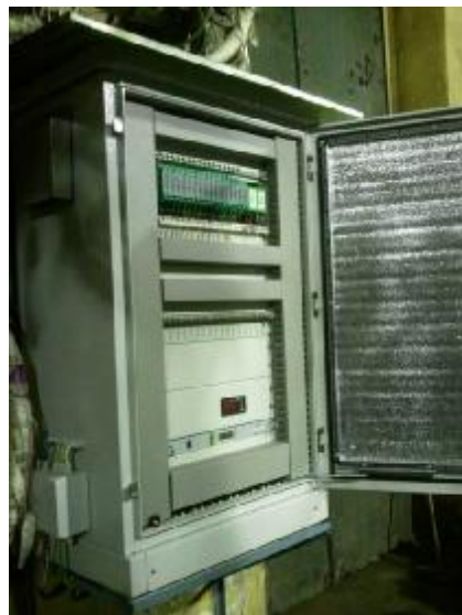
Рисунок 2 – Шкаф температурных преобразователей
