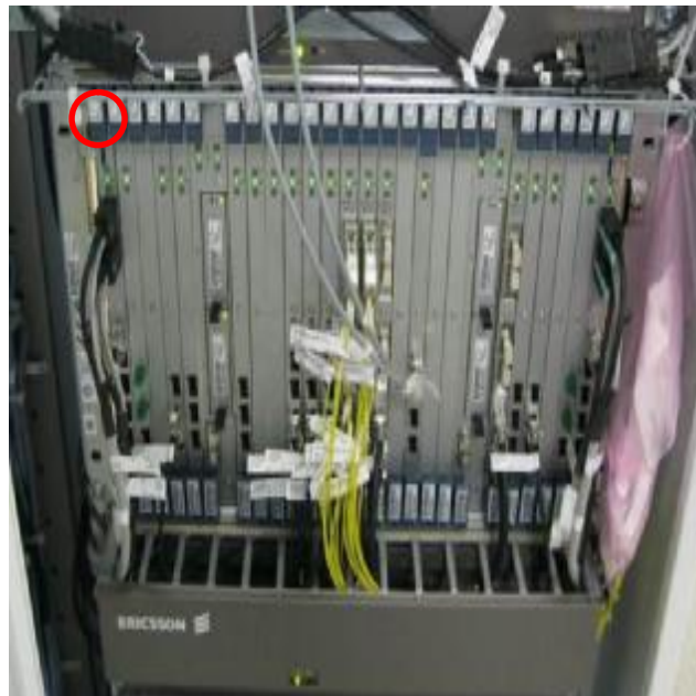
Рисунок 2 Место блокировки кассетного модуля (выделено)
