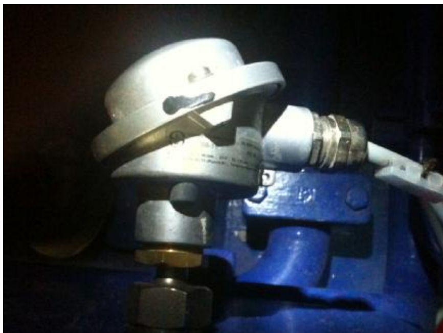
Рис. 1. Термопреобразователь сопротивления платиновый WT-BB-11
