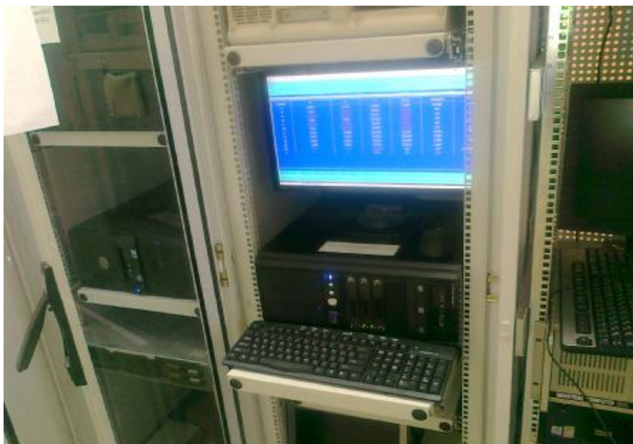
Рисунок 2 – Сервер системы автоматизированной информационно-измерительной коммерческого учета теплоносителей ПАУПЭР.
