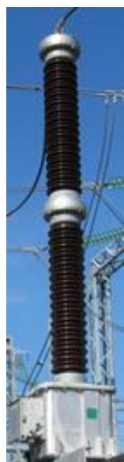
Конструктивно трансформаторы представляют собой бак с установленным на нем изолятором из фарфора (покрышкой) с глазурью коричневого цвета. Трансформаторы состоят из емкостного делителя напряжения и электромагнитного устройства (ЭМУ).
