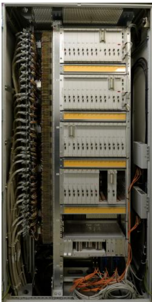
Рисунок 1 – Внешний вид электротехнического шкафа с средствами программно-техническими ТПТС-ЕМ
