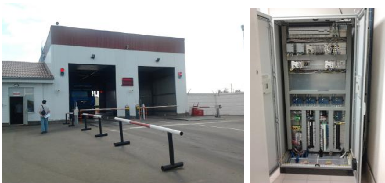
а б а - весоизмерительная платформа весов автомобильных SCZ/ZCS(VTS)-60; б - ЩСУ
