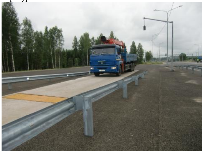
Рисунок 1- Общий вид весов автоматических для взвешивания транспортных средств в движении и измерения нагрузок на оси SUPAWEIGH 5000с
