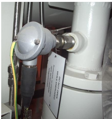
Рисунок 1 - Внешний вид преобразователя термоэлектрического с двумя термопарами
