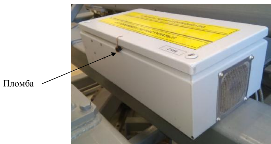
Рисунок 2 – Место установки пломбы на измерительном блоке
