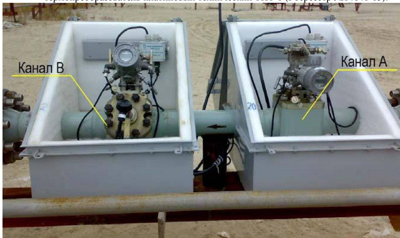
Для подготовки потока к измерению перед НСУ (канал В) установлено ССУ (канал А), которое обеспечивает отрыв жидкой фазы от стенок трубопровода.
