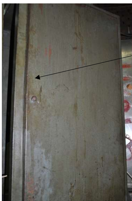
Рисунок 2 - Схема пломбировки от несанкционированного доступа
