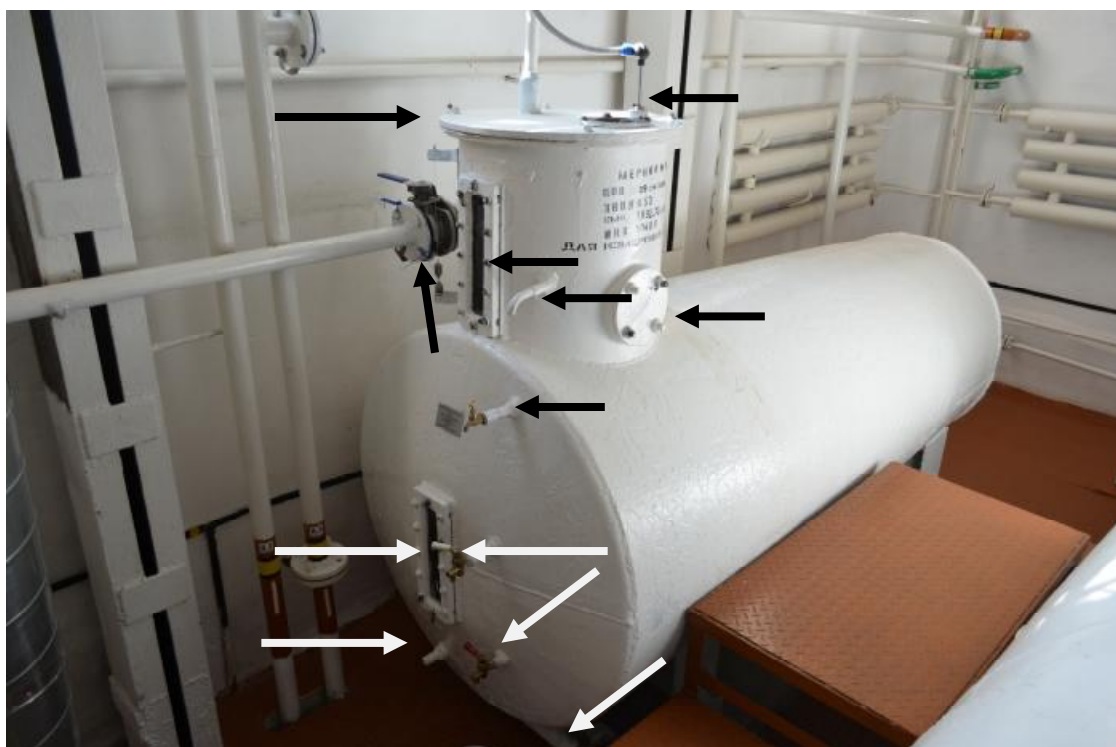
Рисунок 1 - Общий вид и места пломбирования мерника
