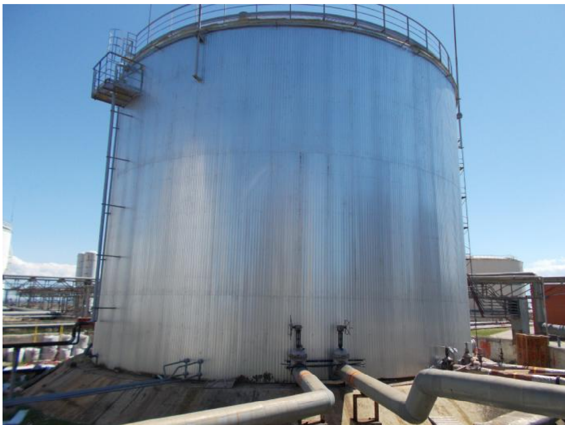
Рисунок 1- Общий вид резервуара № 17
