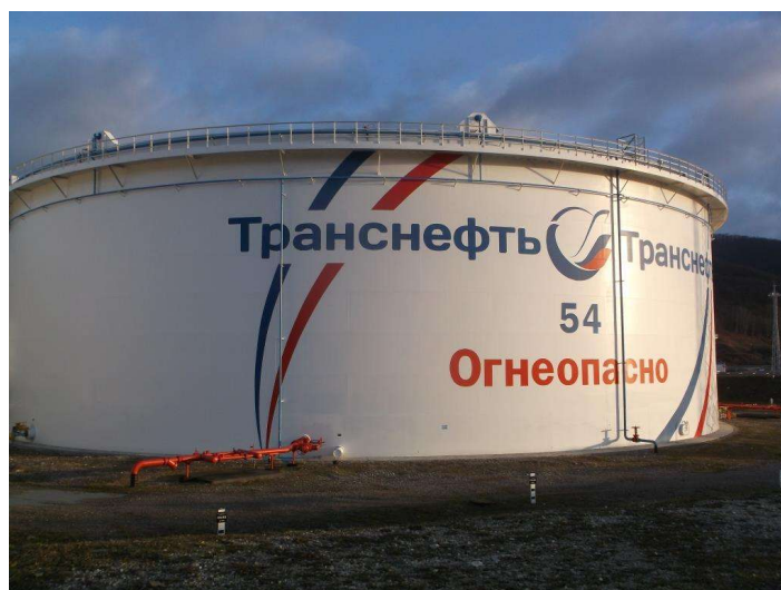
Рисунок 1 - Общий вид резервуара
