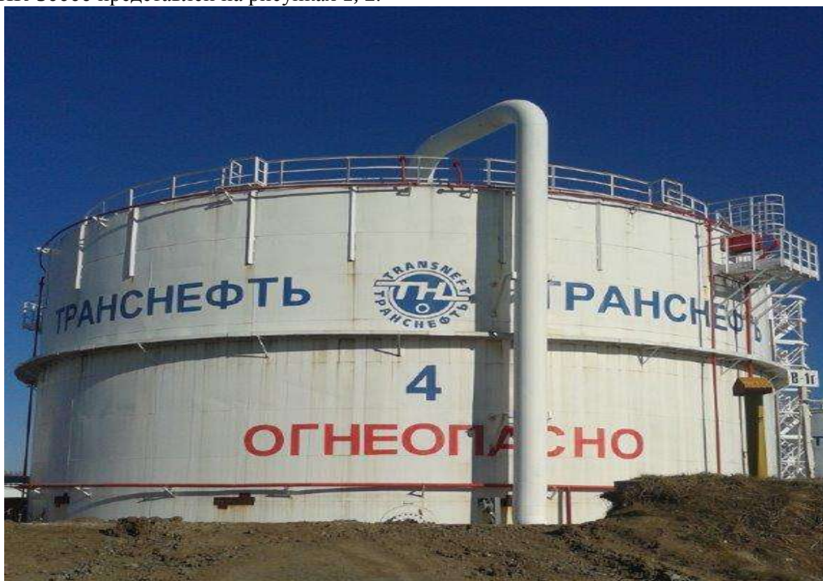
Рисунок 1 - Общий вид резервуара вертикального стального цилиндрического РВС-5000
