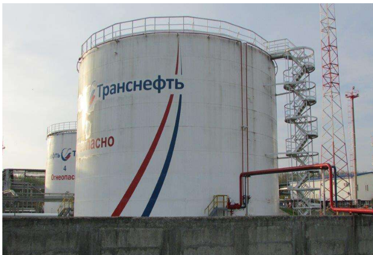
Рисунок 2 - Общий вид резервуара вертикального стального цилиндрического РВС-3000
