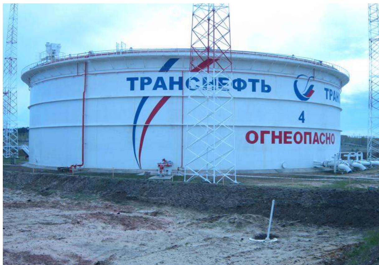
Рисунок 7 - Общий вид резервуара вертикального стального цилиндрического РВСПК-50000
