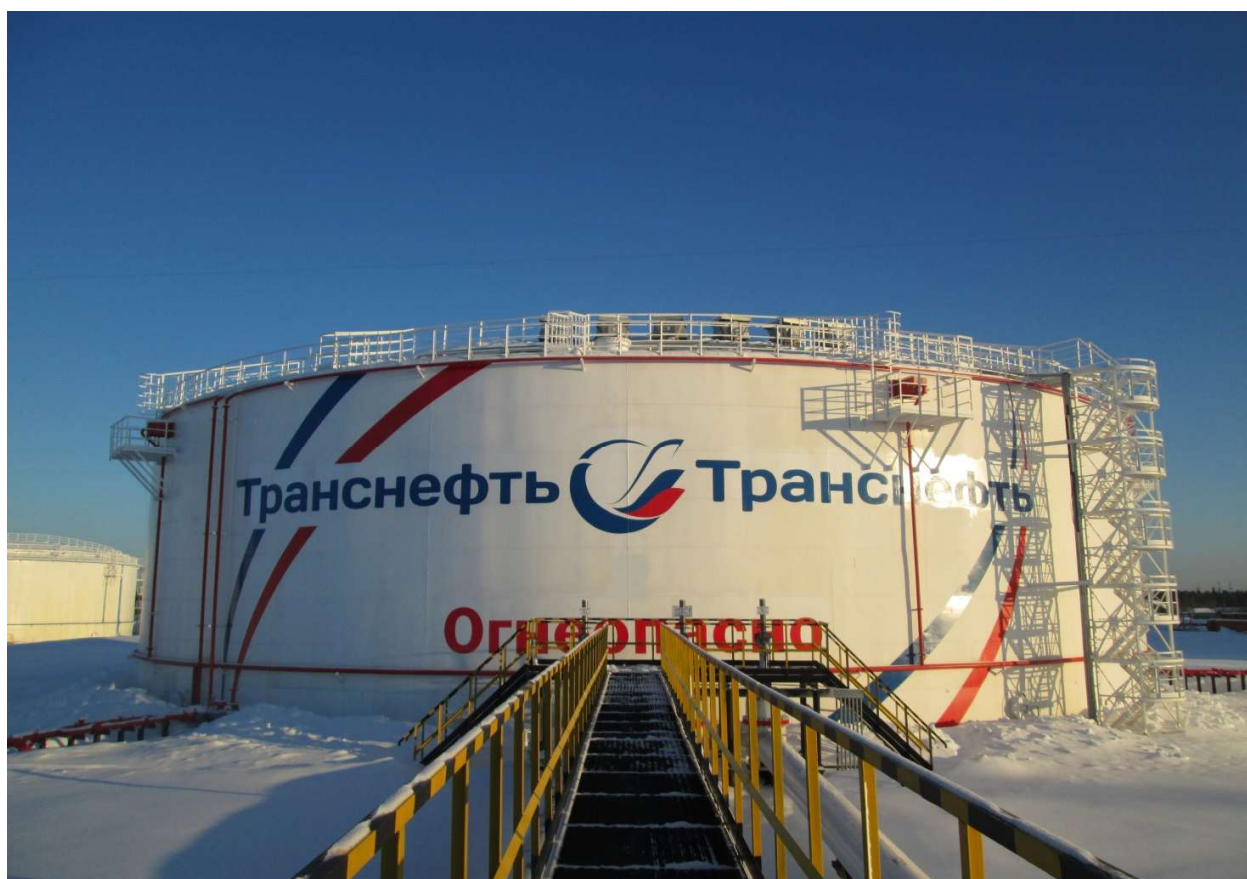
Рисунок 6 - Общий вид резервуара вертикального стального цилиндрического РВС-20000
