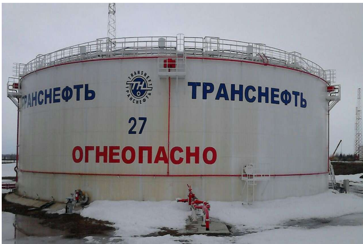
Рисунок 2 - Общий вид резервуара вертикального стального цилиндрического РВСП-20000
