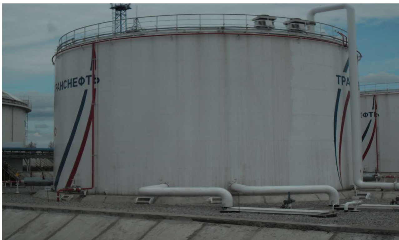
Рисунок 2 - Общий вид резервуара вертикального стального цилиндрического РВСП-5000
