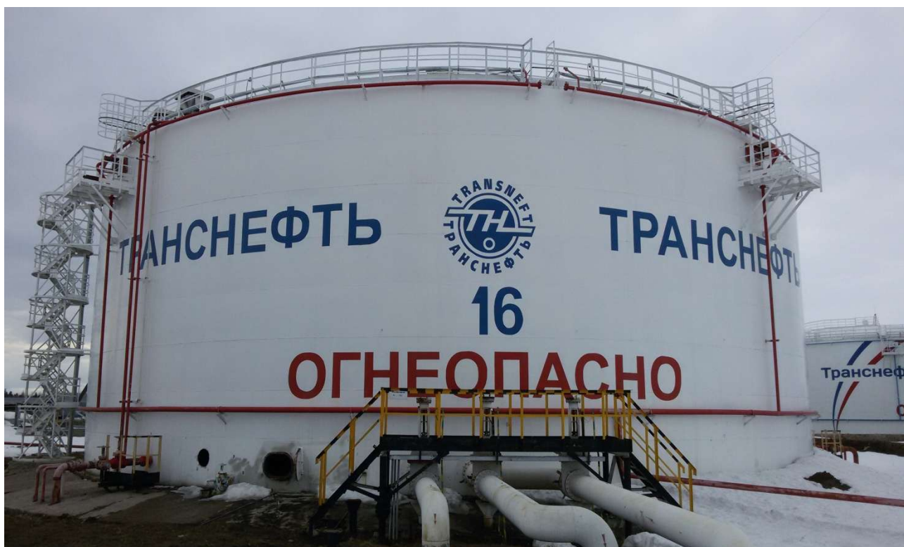
Рисунок 3 - Общий вид резервуара вертикального стального цилиндрического РВС-10000
