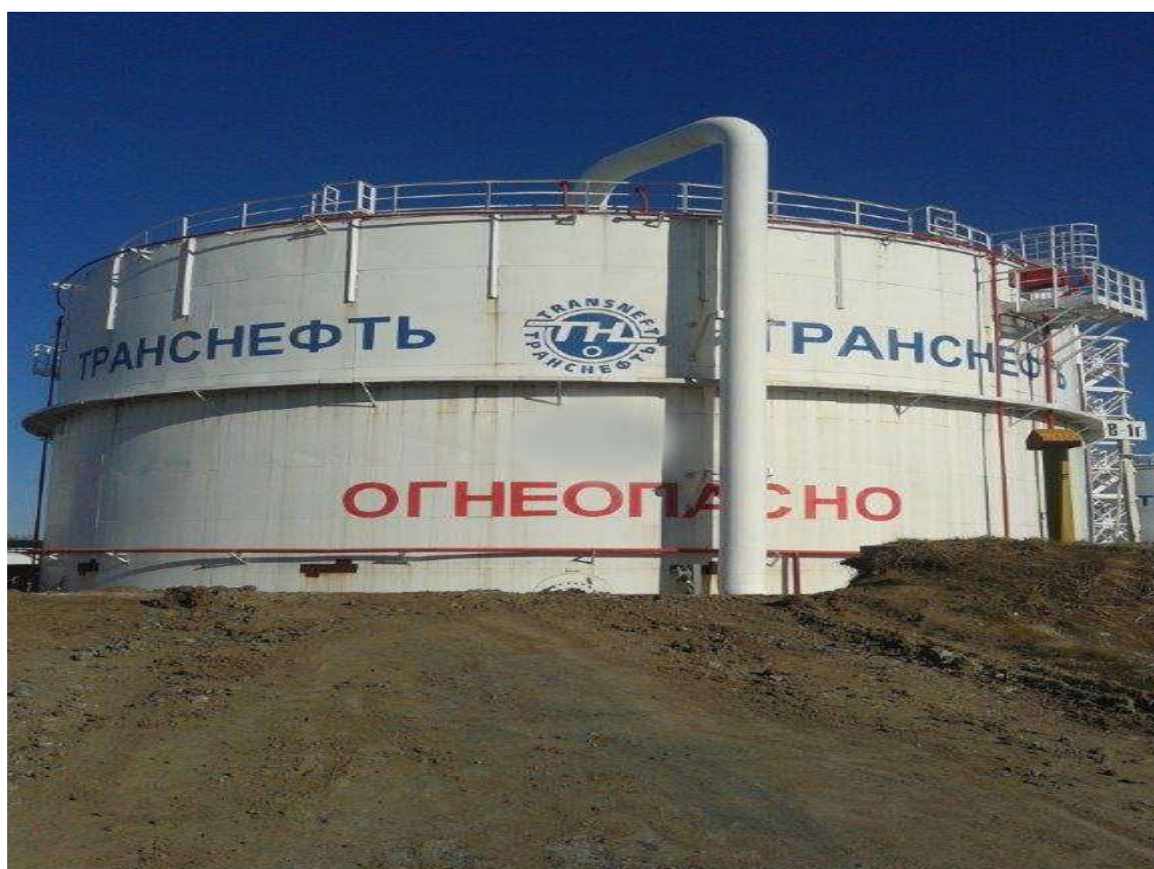
Рисунок 1 - Общий вид резервуара вертикального стального цилиндрического РВС-5000
