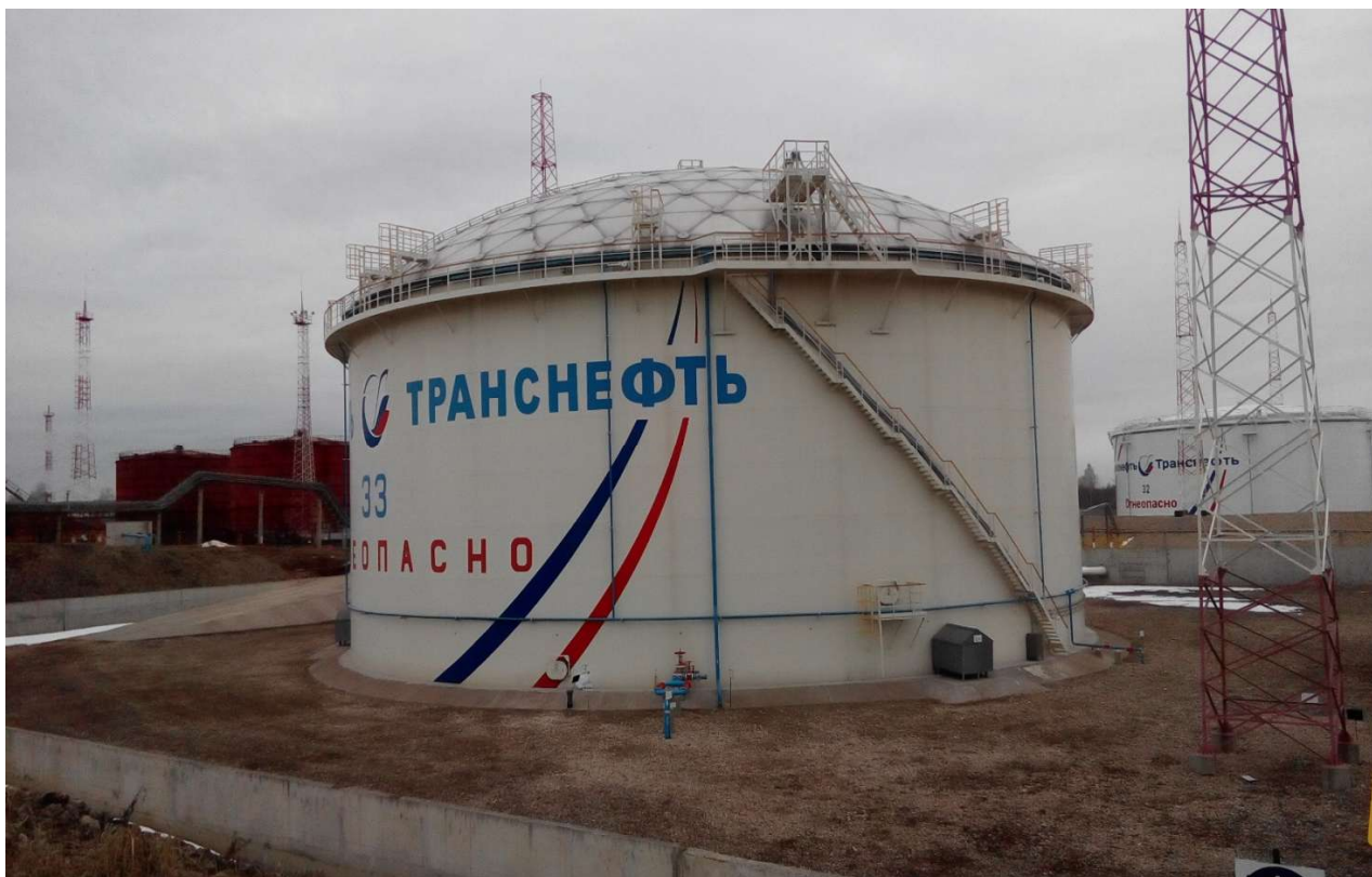
Рисунок 6 - Общий вид резервуара вертикального стального цилиндрического РВСП-30000
