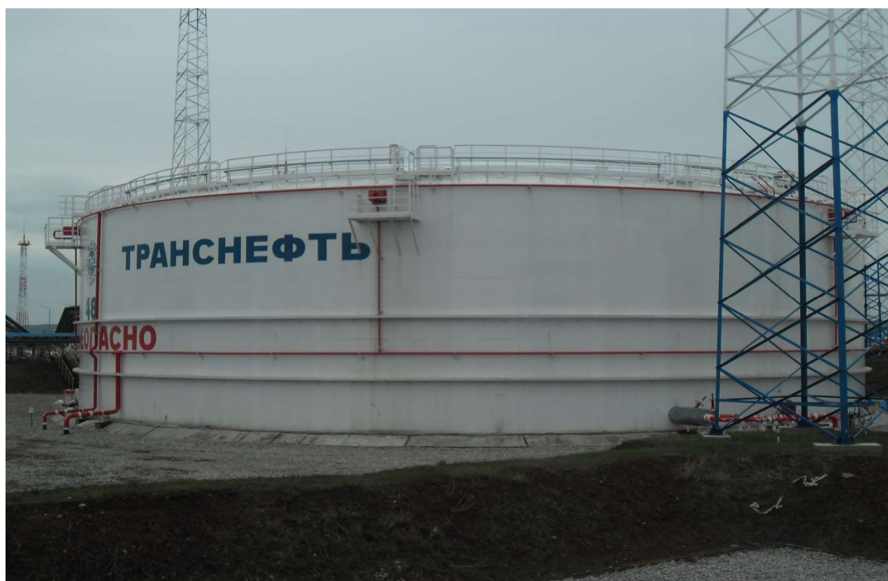
Рисунок 5 - Общий вид резервуара вертикального стального цилиндрического РВС-20000
