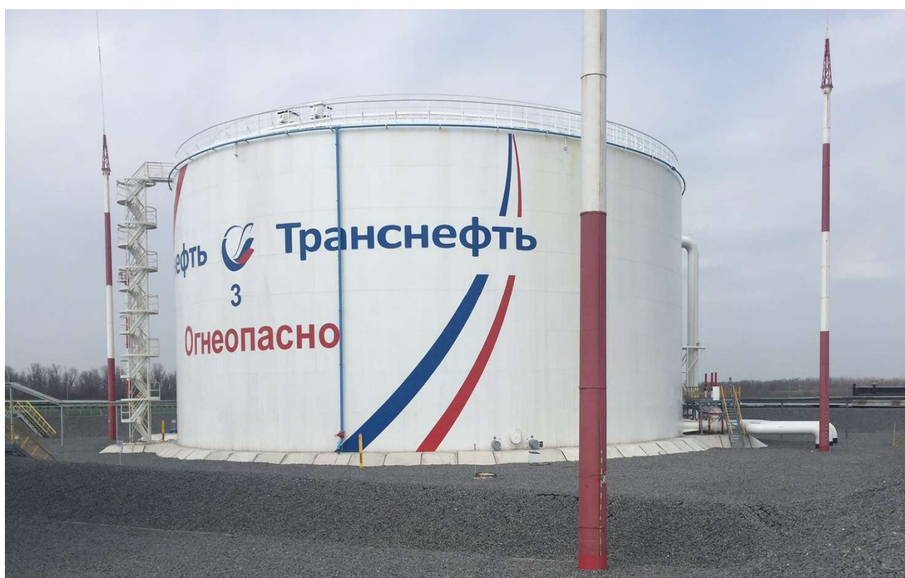
Рисунок 3 - Общий вид резервуара вертикального стального цилиндрического РВС-20000
