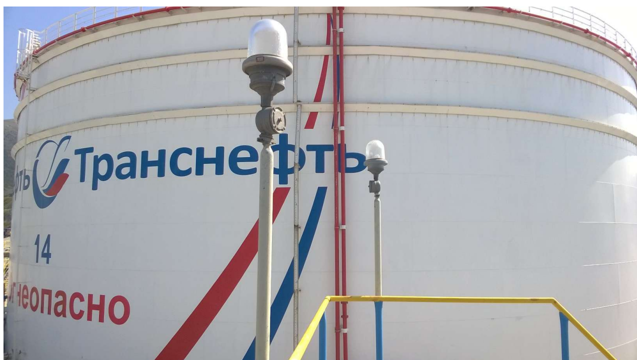
Рисунок 5 - Общий вид резервуара вертикального стального цилиндрического РВС-30000
