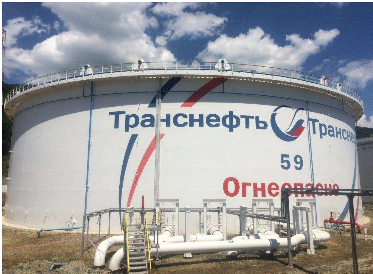
Рисунок 6 - Общий вид резервуара вертикального стального цилиндрического РВСПК-50000
