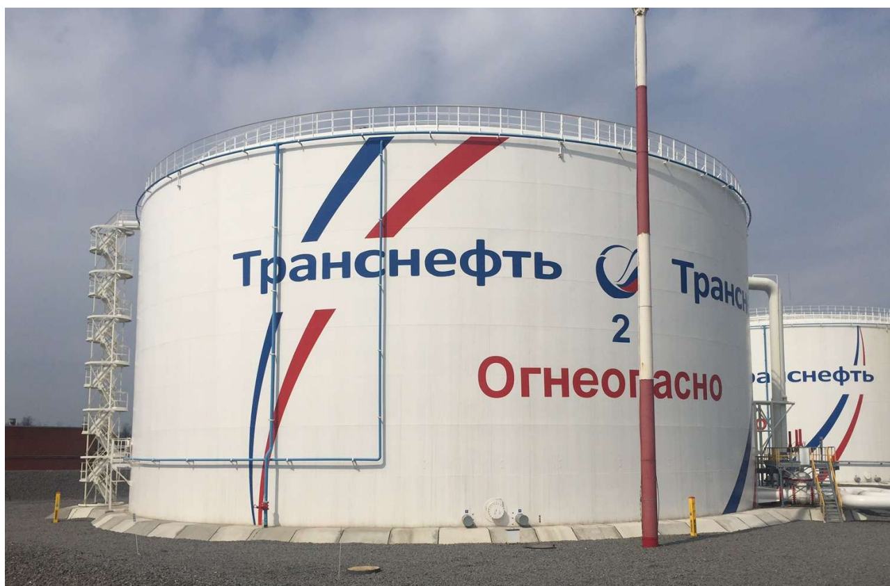
Рисунок 4 - Общий вид резервуара вертикального стального цилиндрического РВСП-20000
