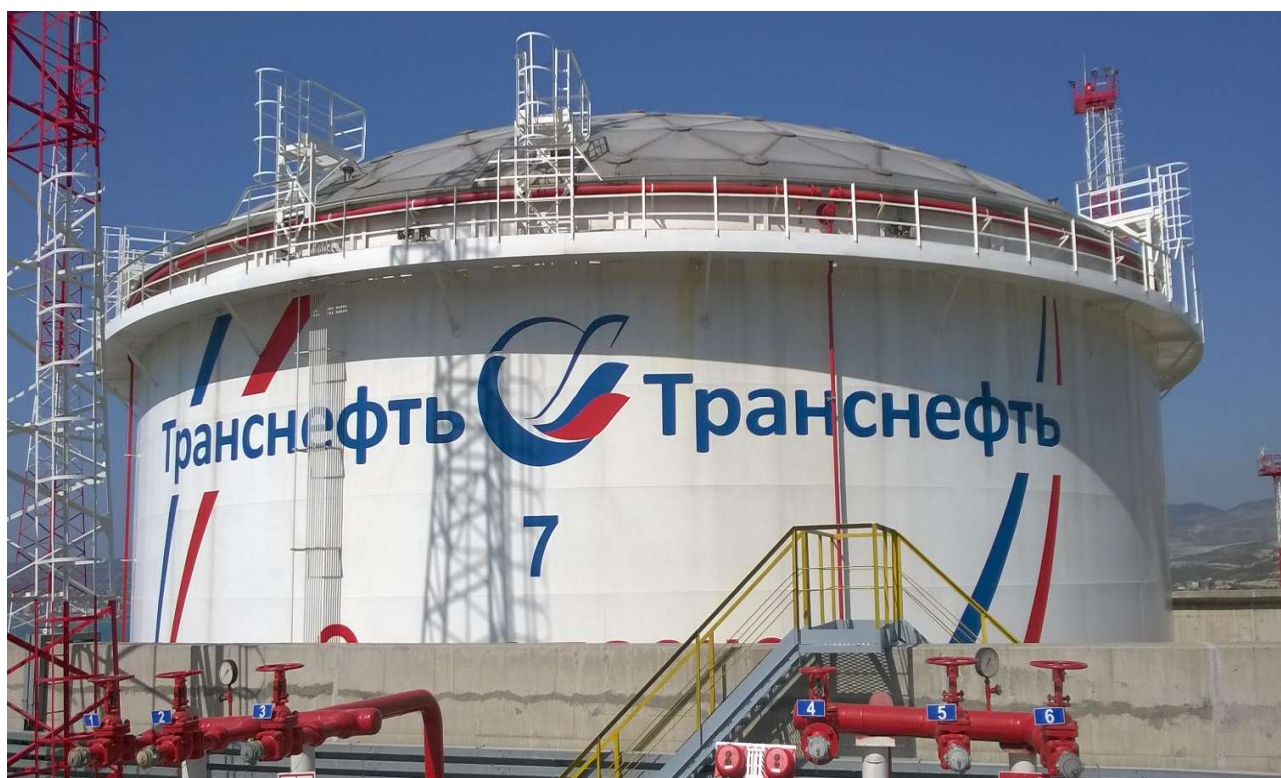
Рисунок 2 - Общий вид резервуара вертикального стального цилиндрического РВСП-10000
