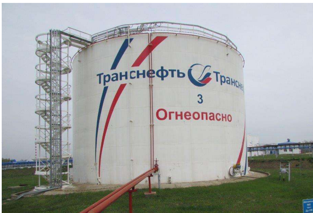
Рисунок 1 - Общий вид резервуара вертикального стального цилиндрического РВС-3000
