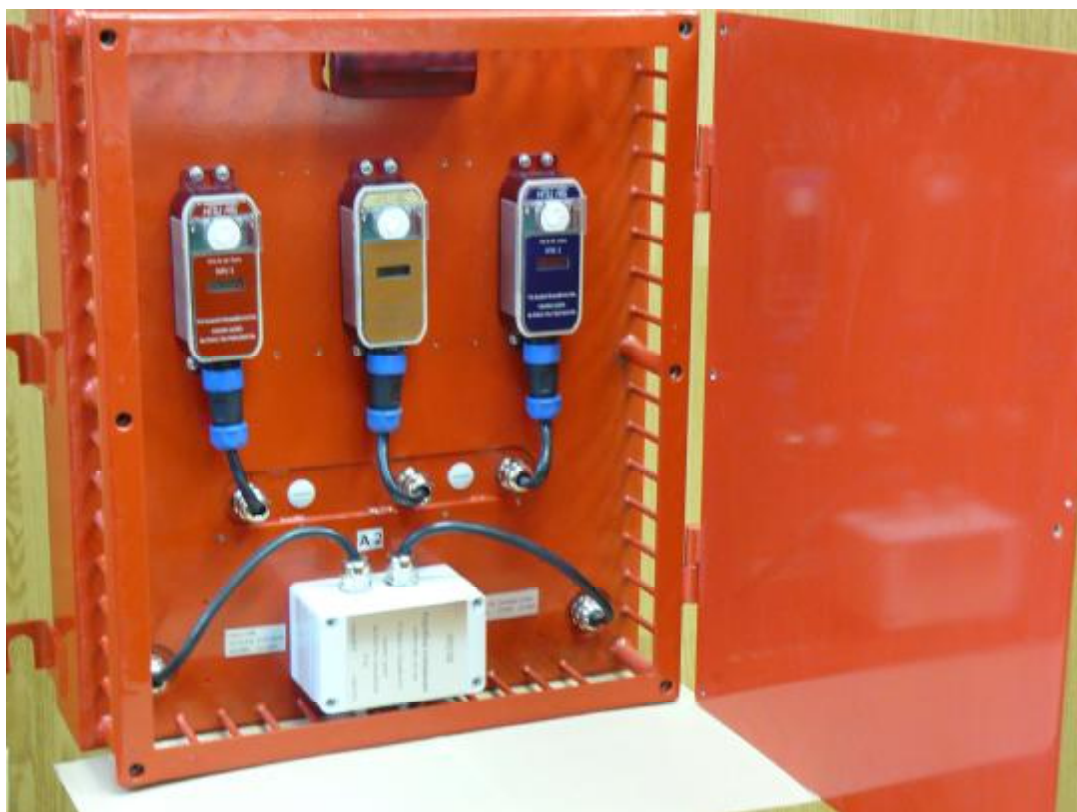
Рисунок 3 – АПНК. Отсек датчиков с открытой крышкой
