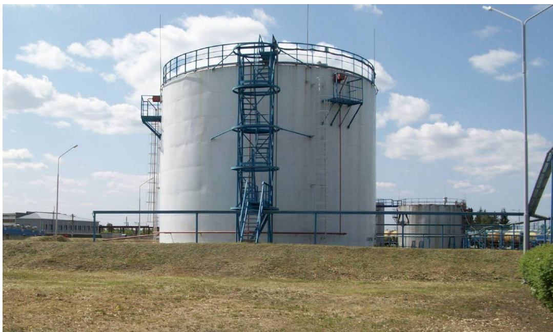
Рисунок 2 - Общий вид резервуара вертикального стального цилиндрического РВСП-2000
