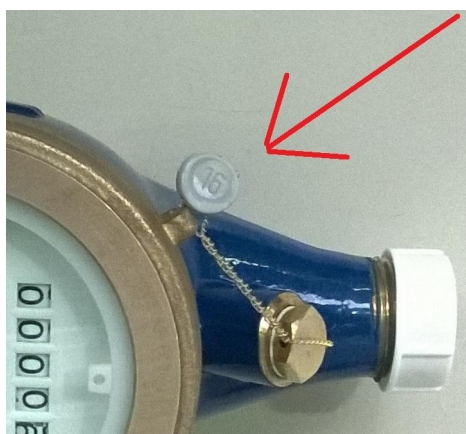
Рисунок 7 - Схема пломбировки счетчиков DS TRP, DS SD, DS TRP V
