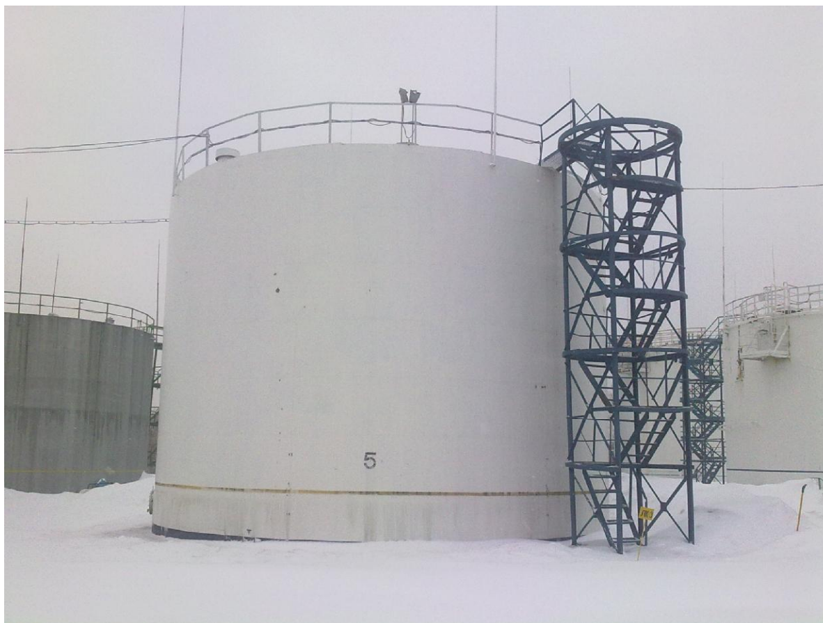
Рисунок 1 - Общий вид резервуара вертикального стального цилиндрического РВС-1000
