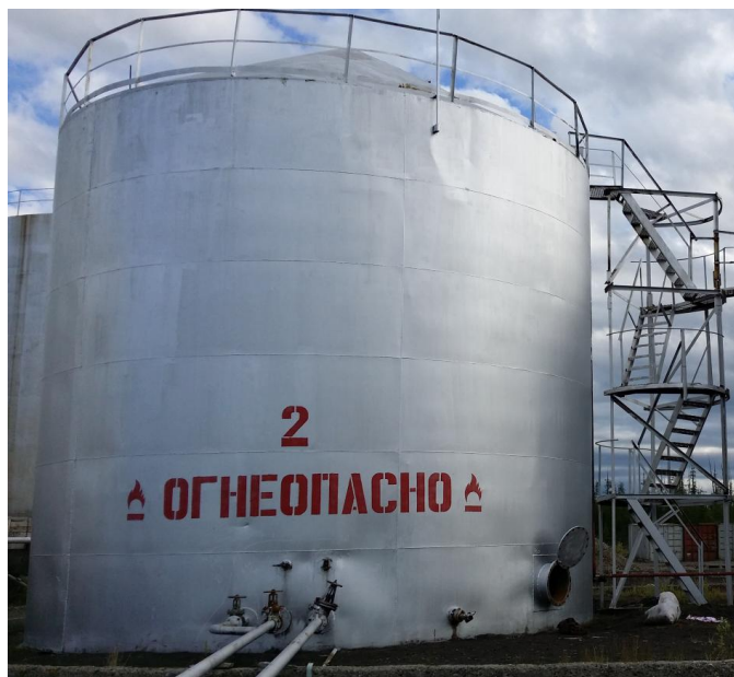
Рисунок 2 - Общий вид резервуара РВС-400
