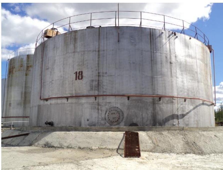
Рисунок 3 - Общий вид резервуара РВС-1000
