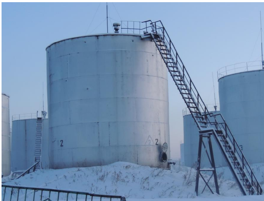
Рисунок 1 - Общий вид резервуара РВС-400
