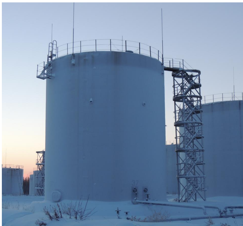
Рисунок 3 - Общий вид резервуара РВС-1000
