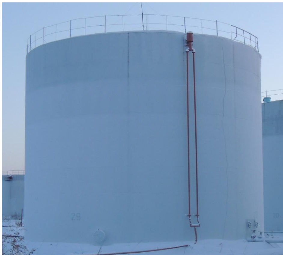
Рисунок 4 - Общий вид резервуара РВС-2000
