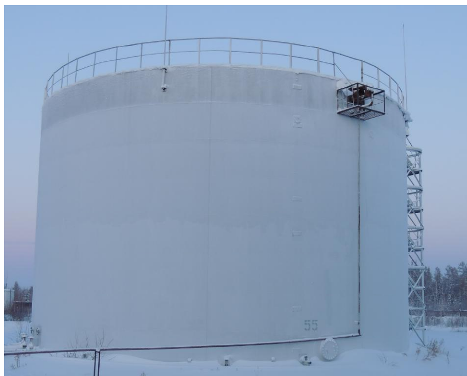
Рисунок 5 - Общий вид резервуара РВС-3000
