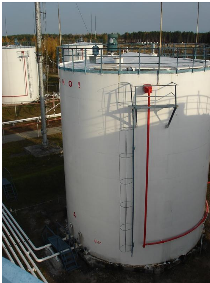
Рисунок 1 - Общий вид резервуара вертикального стального цилиндрического РВС-1000
