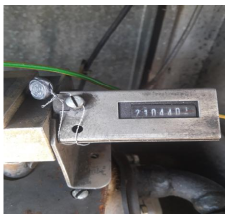
Рисунок 2 - Пломбирование суммарного счетчика
