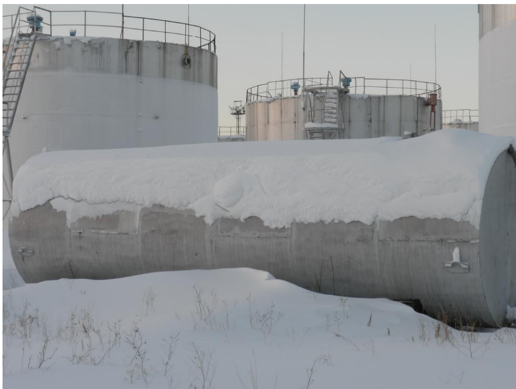
Рисунок 1 - Общий вид резервуара РГС-50
