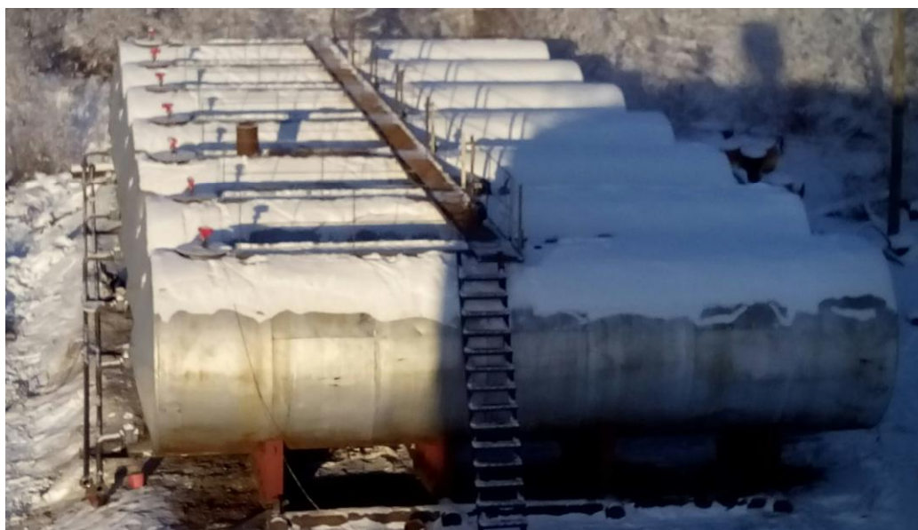
Рисунок 2 - Общий вид резервуара РГС-60
