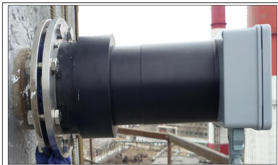
Рисунок 3 - Анализатор пыли LaserDust на месте установки (показан только один из двух блоков)
