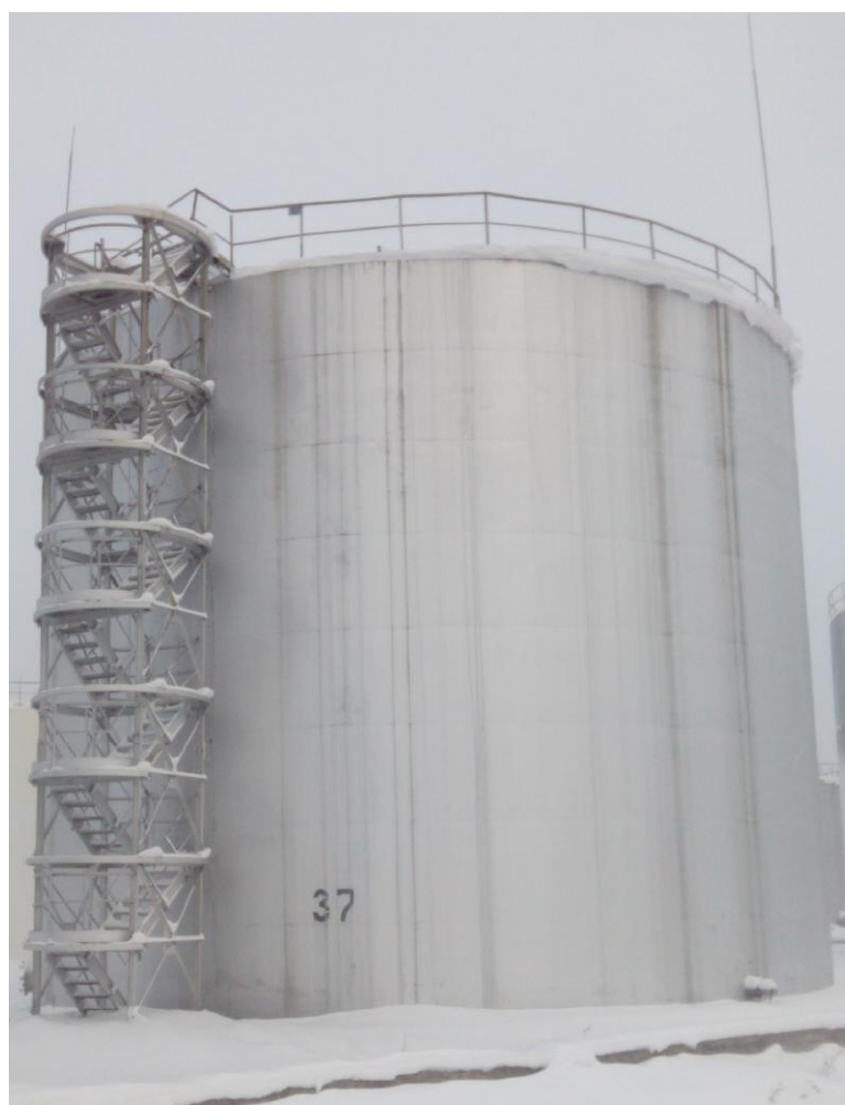
Рисунок 5 - Общий вид резервуара РВС-2000
