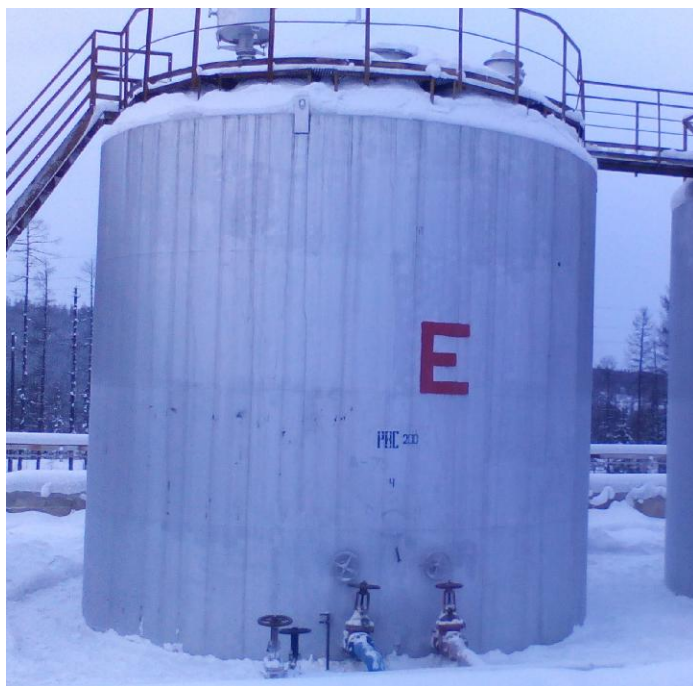
Рисунок 2 - Общий вид резервуара РВС-200
