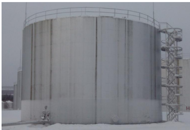
Рисунок 6 - Общий вид резервуара РВС-3000
