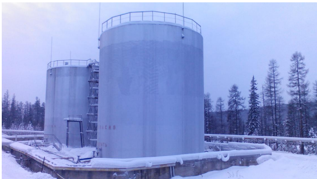
Рисунок 4 - Общий вид резервуара РВС-1000
