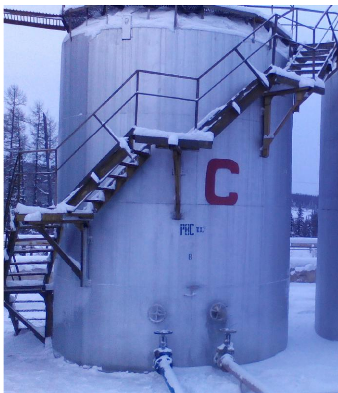
Рисунок 1 - Общий вид резервуара РВС-100
