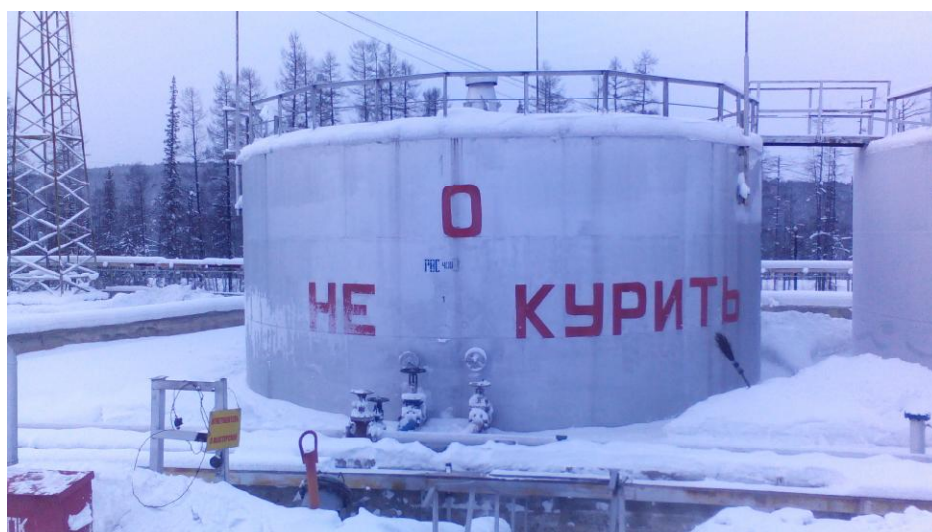
Рисунок 3 - Общий вид резервуара РВС-400
