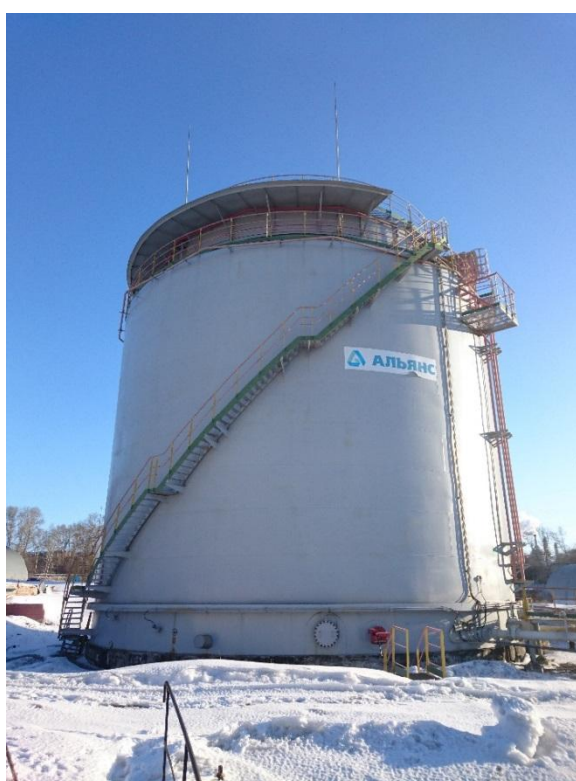
Рисунок 3 - Общий вид резервуара РВСПзс-3000
