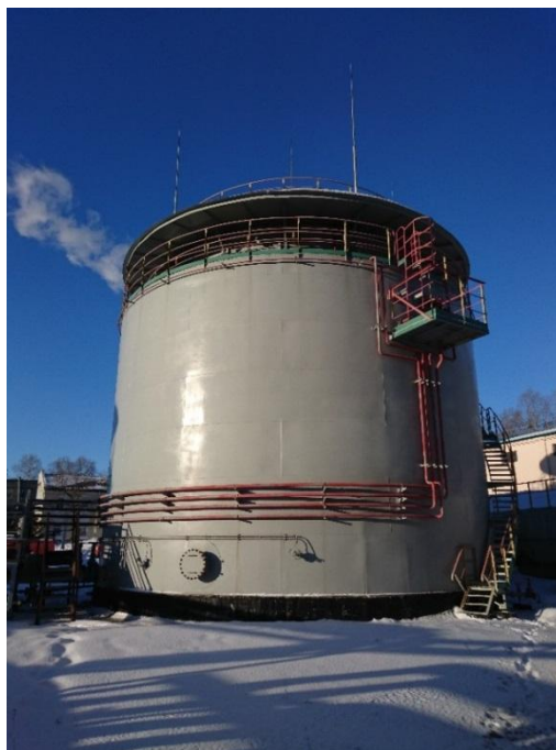
Рисунок 1 - Общий вид резервуара РВСПзс-1000
