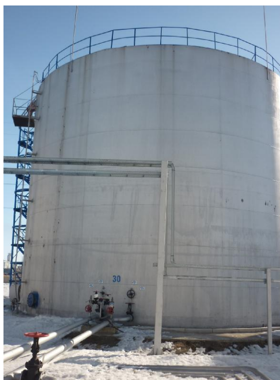
Рисунок 3 - Общий вид резервуара вертикального стального цилиндрического РВС-2000
