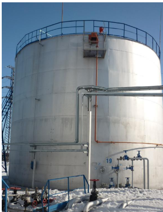
Рисунок 2 - Общий вид резервуара вертикального стального цилиндрического РВС-1000
