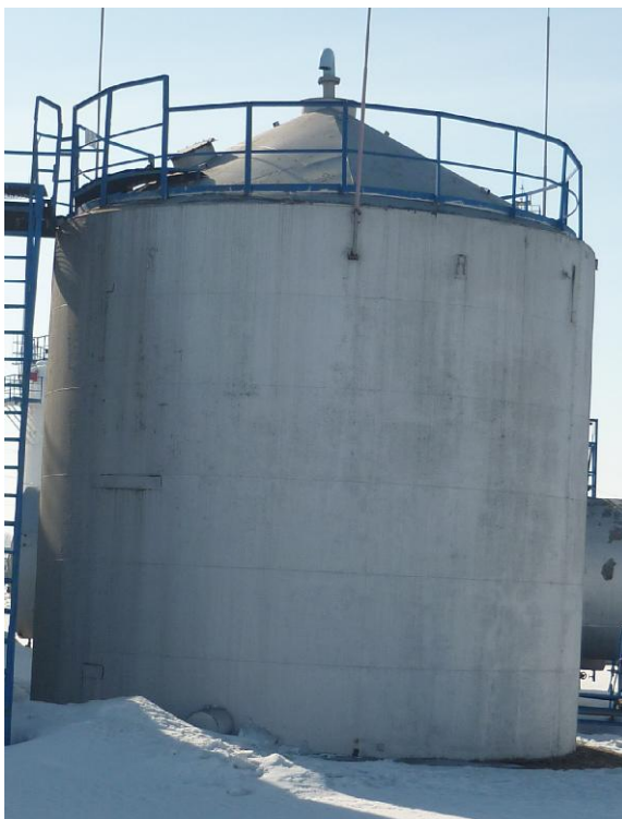
Рисунок 1 - Общий вид резервуара вертикального стального цилиндрического РВС-200
