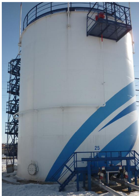
Рисунок 4 - Общий вид резервуара вертикального стального цилиндрического РВСП-1000
