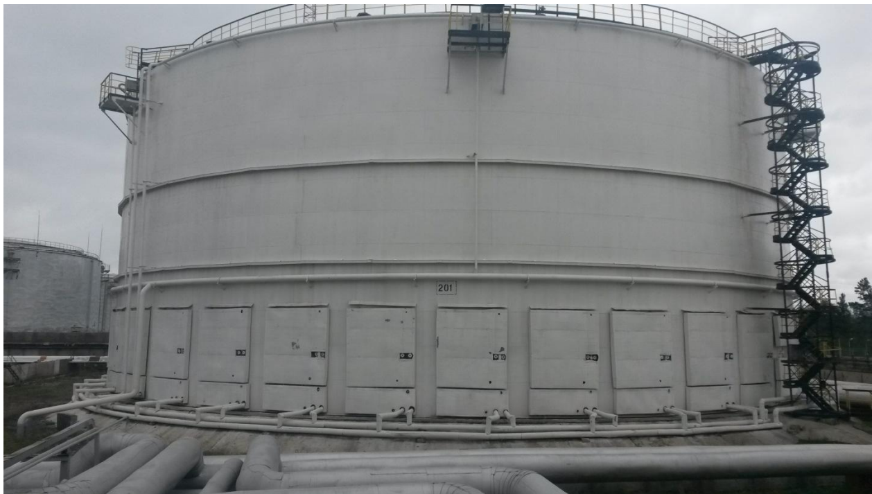
Рисунок 1 - Общий вид резервуара РВСП-30000
