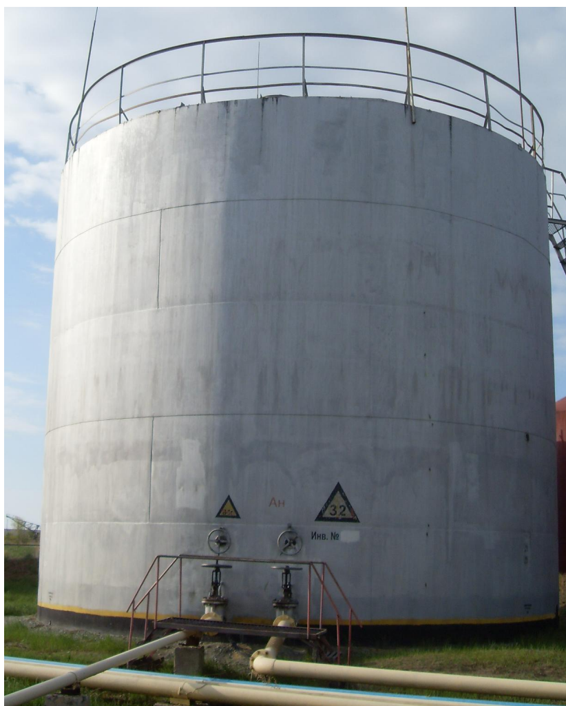
Рисунок 1 – Общий вид резервуара вертикального стального цилиндрического РВС-400
