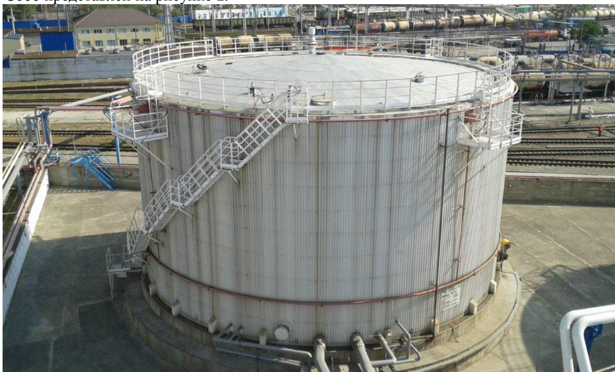
Рисунок 1 – Общий вид резервуара РВС-5000
